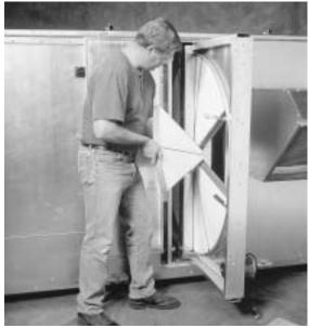
**IMPORTANT!** PLACE RETAINERS BACK IN THE ORIGINAL POSITION BEFORE ROTATING THE ENERGY RECOVERY WHEEL. OTHERWISE DAMAGE TO RETAINER WILL OCCUR.
